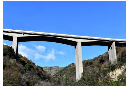
Viadotto Veilino PILE CON ALTEZZE MOLTO DISUNIFORMI
