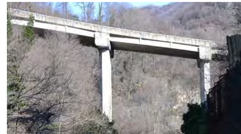
Ponte Lambro IMPALCATI SGHEMBI e IN CURVA
